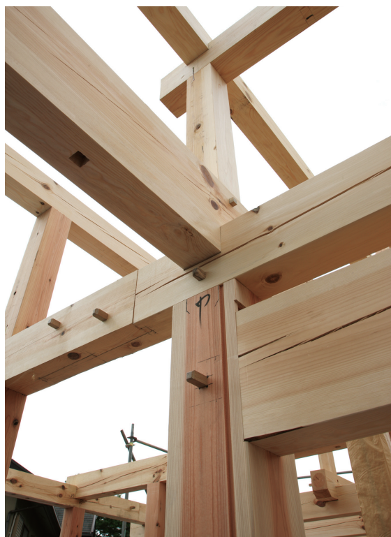
通常より太い柱を使用し、 耐久性・耐震性を高める
