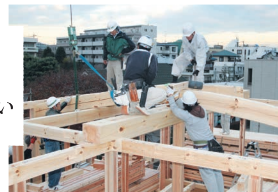
直線の柱・梁と違い、登り梁をくみ上げる時は大工さんもドキドキ！
