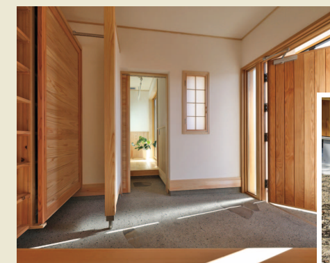
玄関仕上げ洗出し（一部天然石埋め込み）
