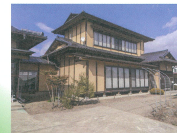
2階建てから平屋に減築
