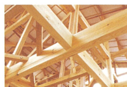
木材の骨組み
